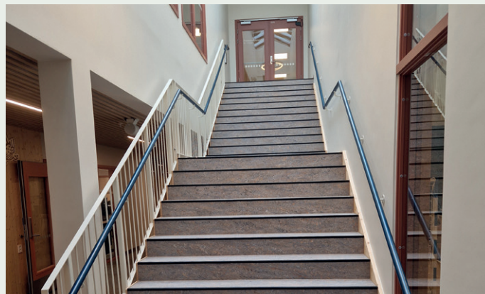
Trappeløp opp til øverste etasje.
